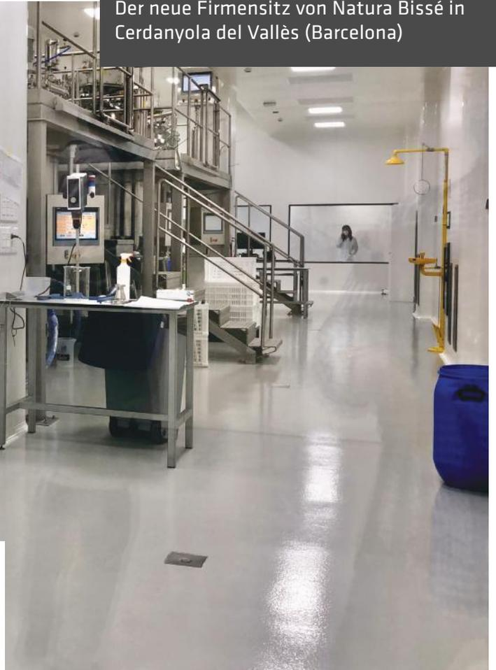
Bei Natura Bissé eingesetzte Stonhard Produkte: HT Primer • Stonclad® GS • Stonclad® LT • Stonkote® HT4
